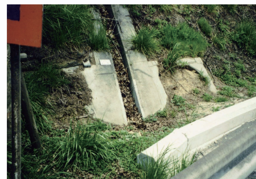
排水溝に土砂等が堆積
