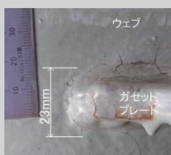
溶接部付近の亀裂
