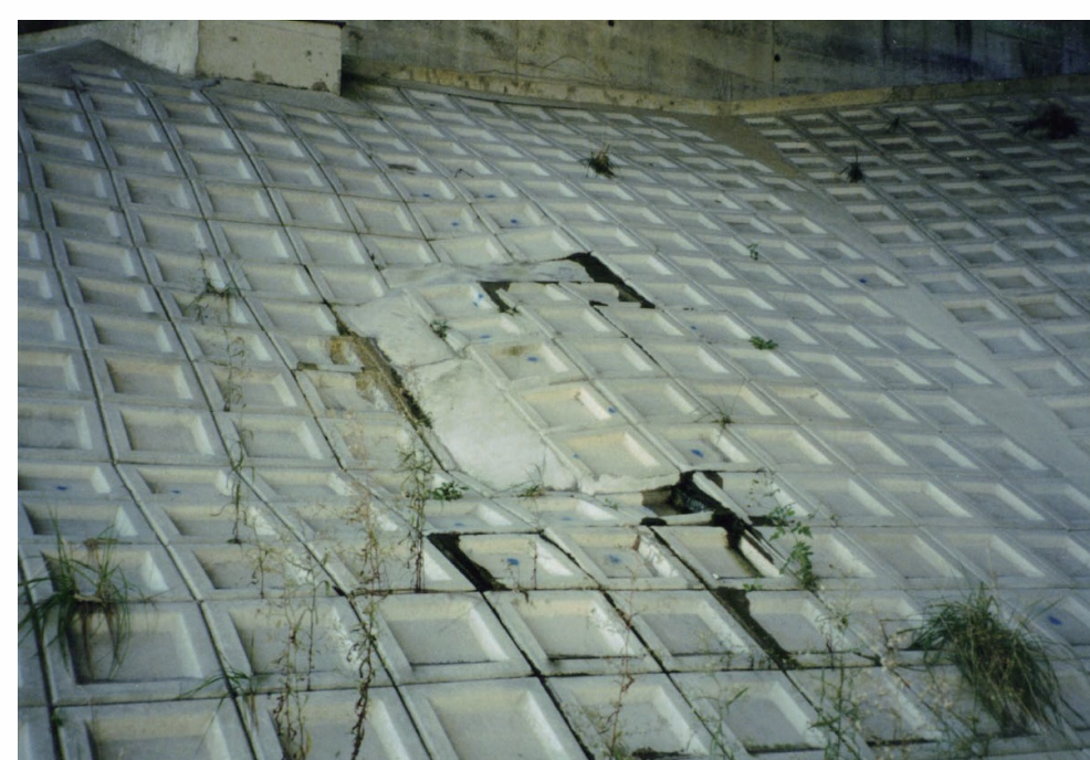
のり面保護工原地盤の沈下
