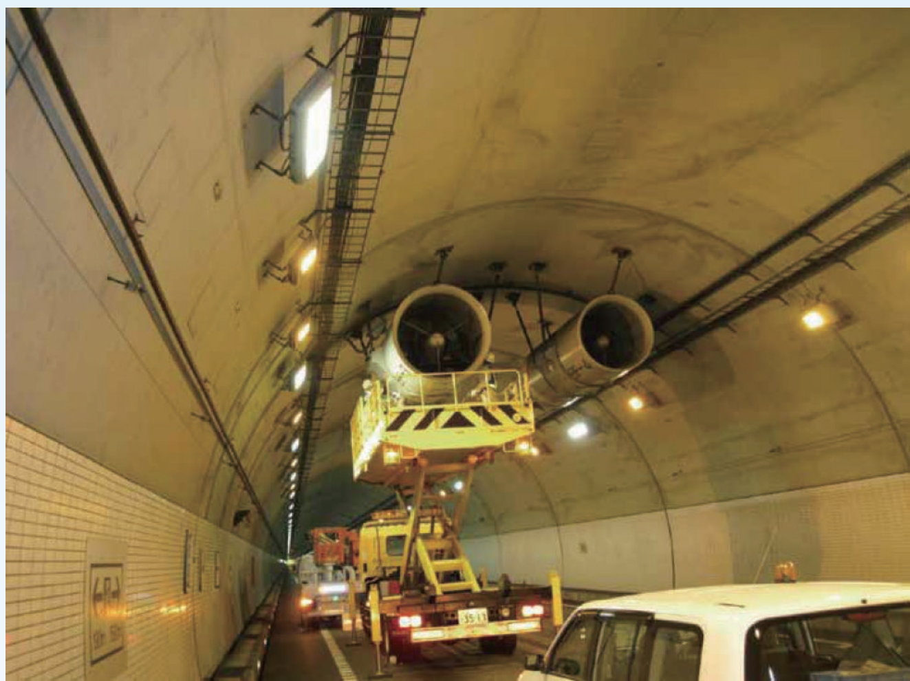
トンネル換気設備の構造検査
