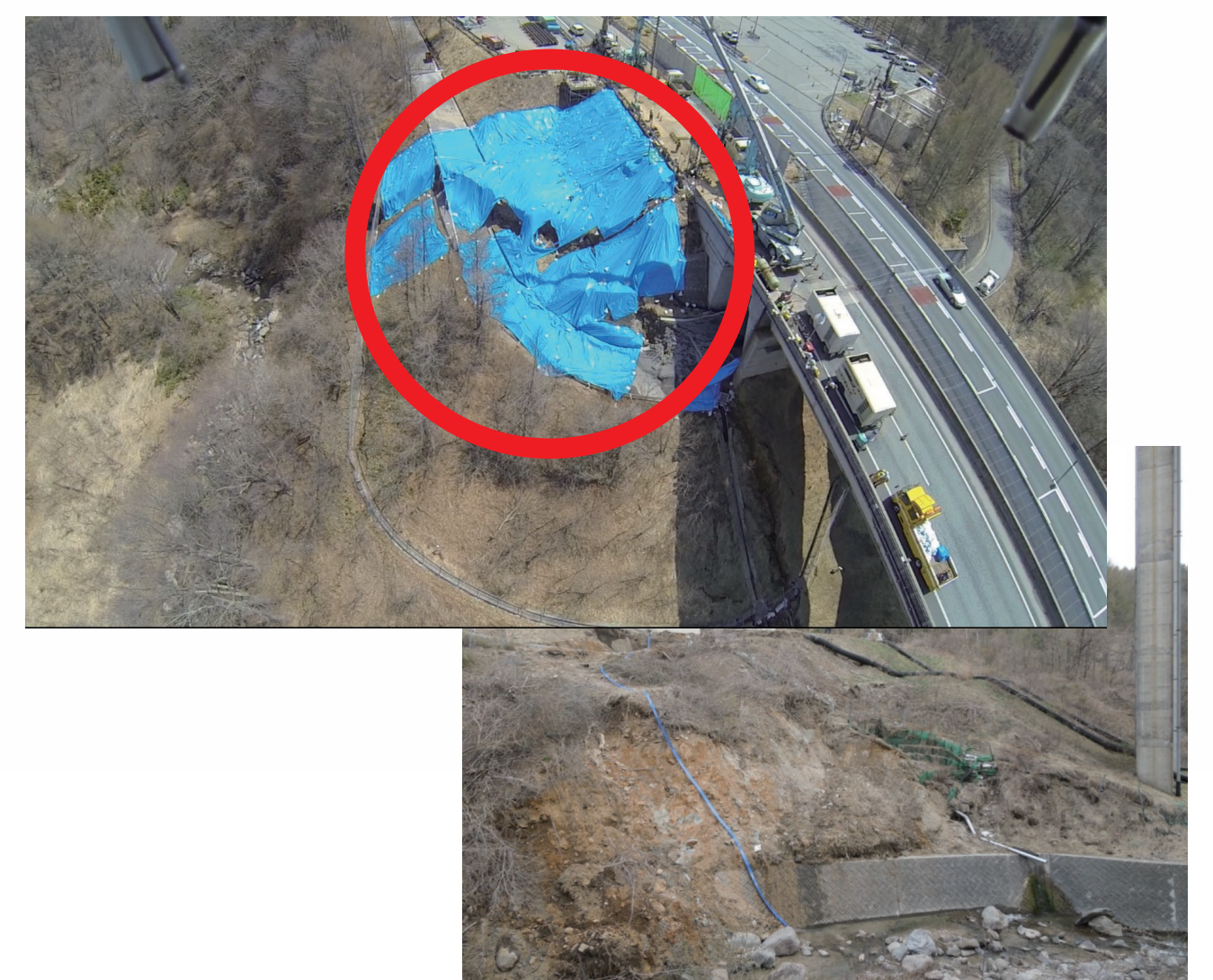
盛土のり面の崩落
